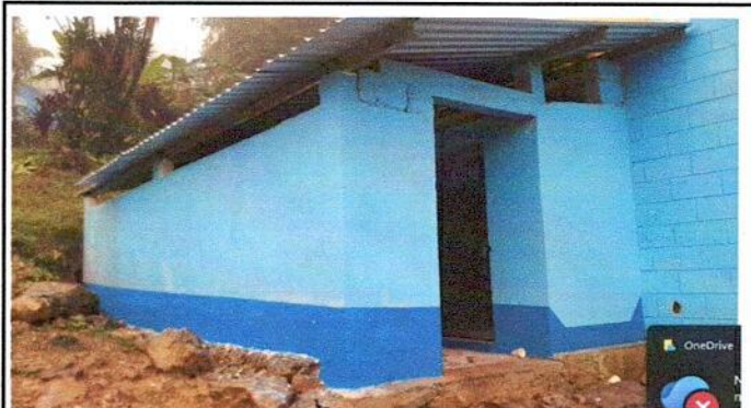
FOTO 4: Sustitución de piso en servicios sanitarios
