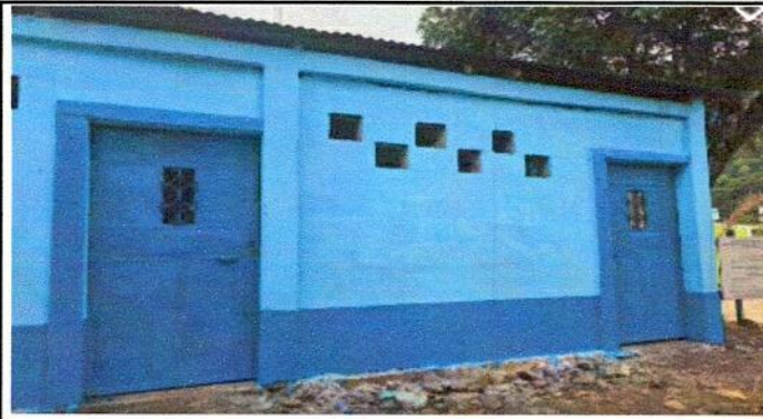
FOTO 1: Reparación de puertas de la cocina
